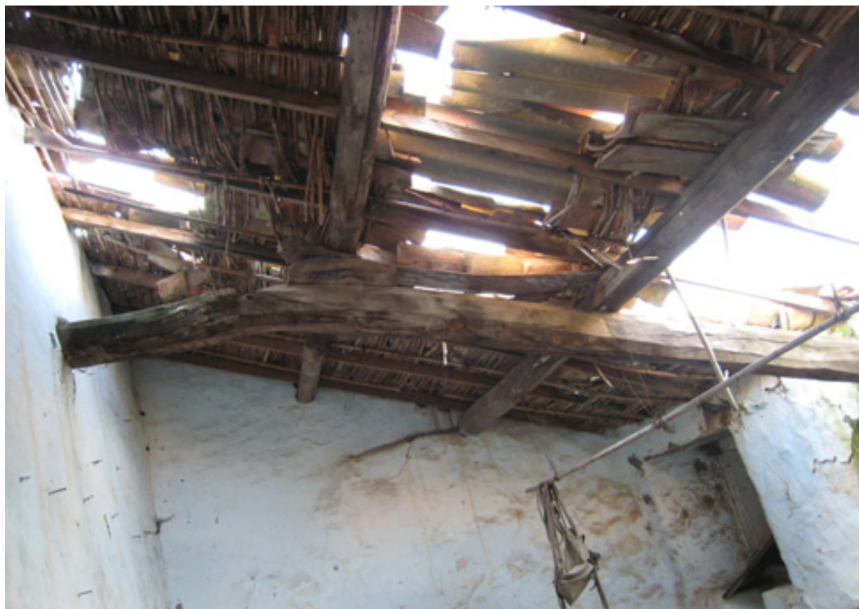
Fig. 4.35. Degrado impalcato. Interno di una casa tradizionale ad Assolo, nell’alta Marmilla.
