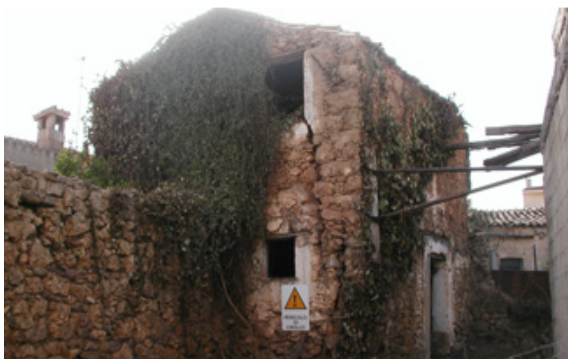
Fig. 4.10. Rotazione paramento murario con distacco del cantonale. Laconi, nel Sarcidano.
