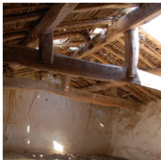
Fig. 4.36. Degrado dell'impalcato. Simala, in Marmilla.
