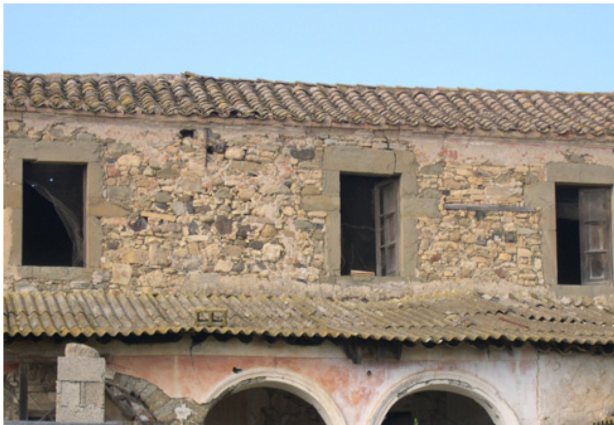
Fig. 4.21. Degrado aperture. Rottura architrave monolitico, in una casa tradizionale a Lanamatrona, nella bassa Marmilla.
