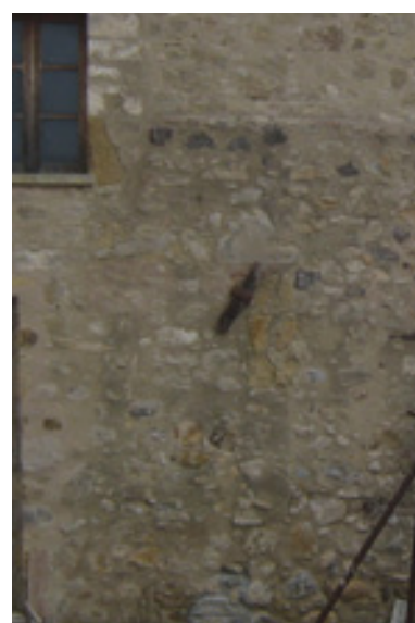
Dall'alto verso il basso: Fig. 4.17, Fig. 4.18. Utilizzo di catena lignea con dispositivo capochiave metallico a Sardara e a Tuili, in Marmilla. Fig. 4.19. Utilizzo di catene a Nurri, nel Sarcidano.
