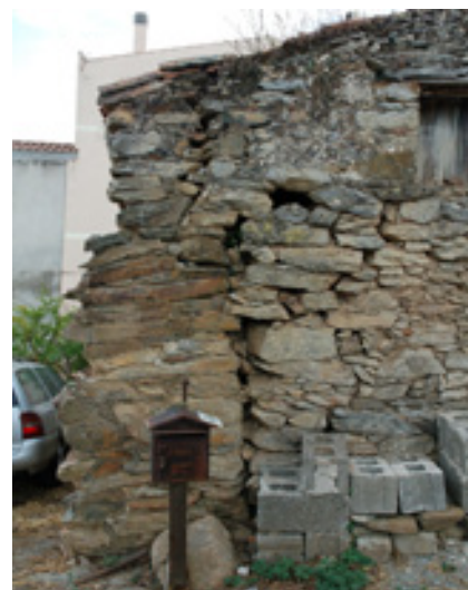
Fig. 4.11, in alto: distacco del cantonale per insufficiente ammorsatura. Villa- salto, nel Gerrei. Fig. 4.12, in basso: utilizzo di speroni murari a Tuili, in Marmilla.
