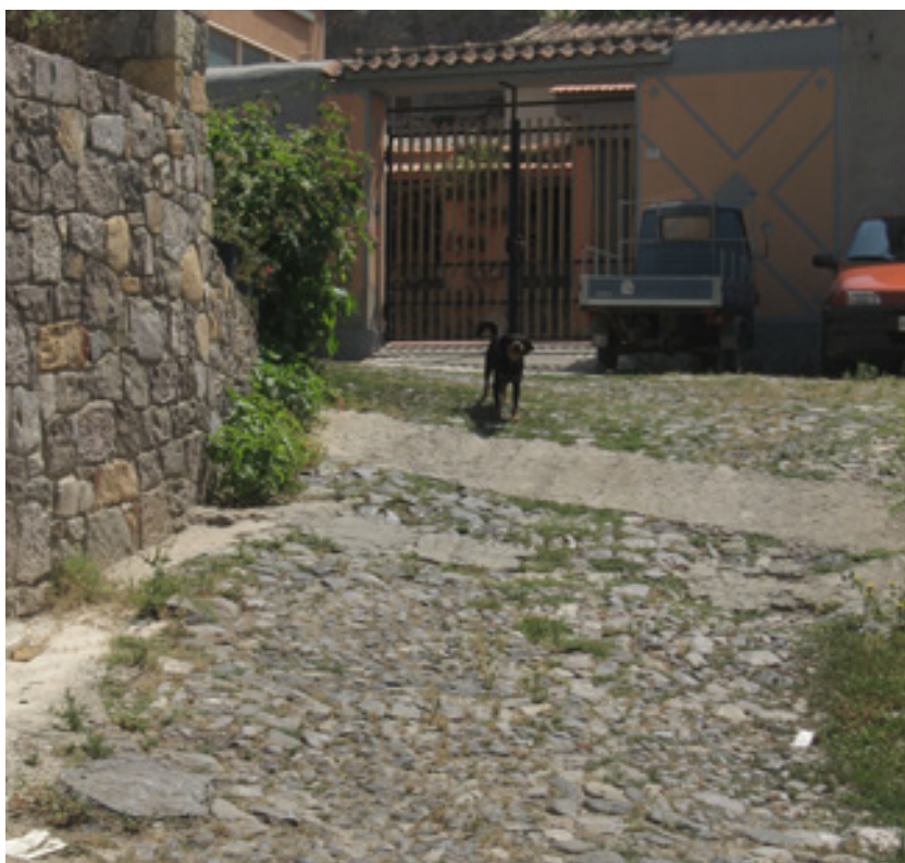
Il degrado delle pavimentazioni storiche. Fig. 4.45, Fig. 4.46. Sardara, nella bassa Marmilla. Il passaggio dei sottoservizi, il cui ripristino viene effettuato con il cemento, è una delle cause di degrado più comuni delle pavimentazioni storiche.
