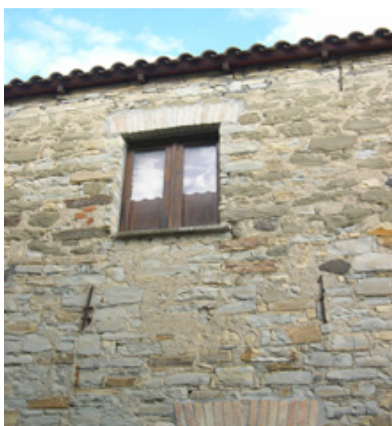
Fig. 4.15, Fig.4.16, dall'alto verso il basso: utilizzo di catena metallica per rinforzare il cantonale a Orroli, nel Sarcidano, e per collegare i setti murari paralleli a Lanamatrona, nella bassa Marmilla.
