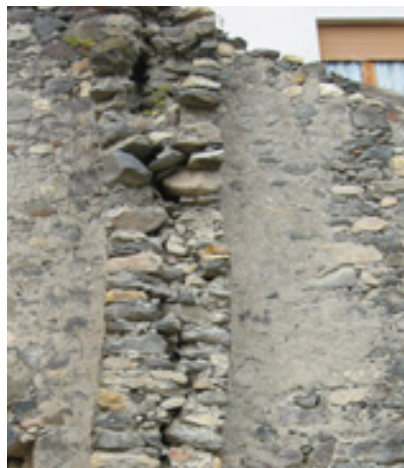
Fig. 4.6, in basso: sezione di un muro a doppio paramento privo di diatoni a Nurri, nel Sarcidano.
