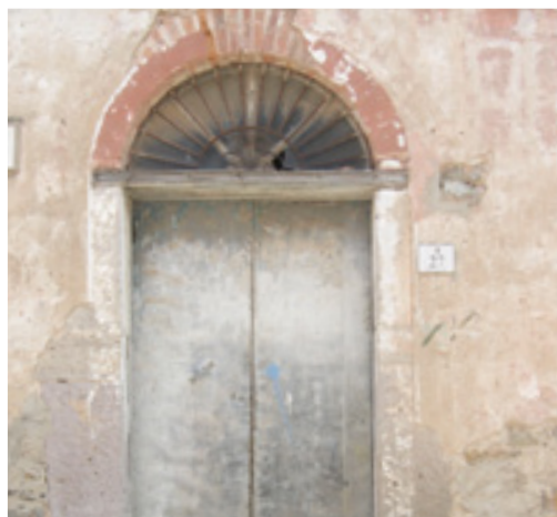
Fig. 4.28. Esempio di sopra luce con arco a tutto sesto a Sardara, nella bassa Marmilla.
