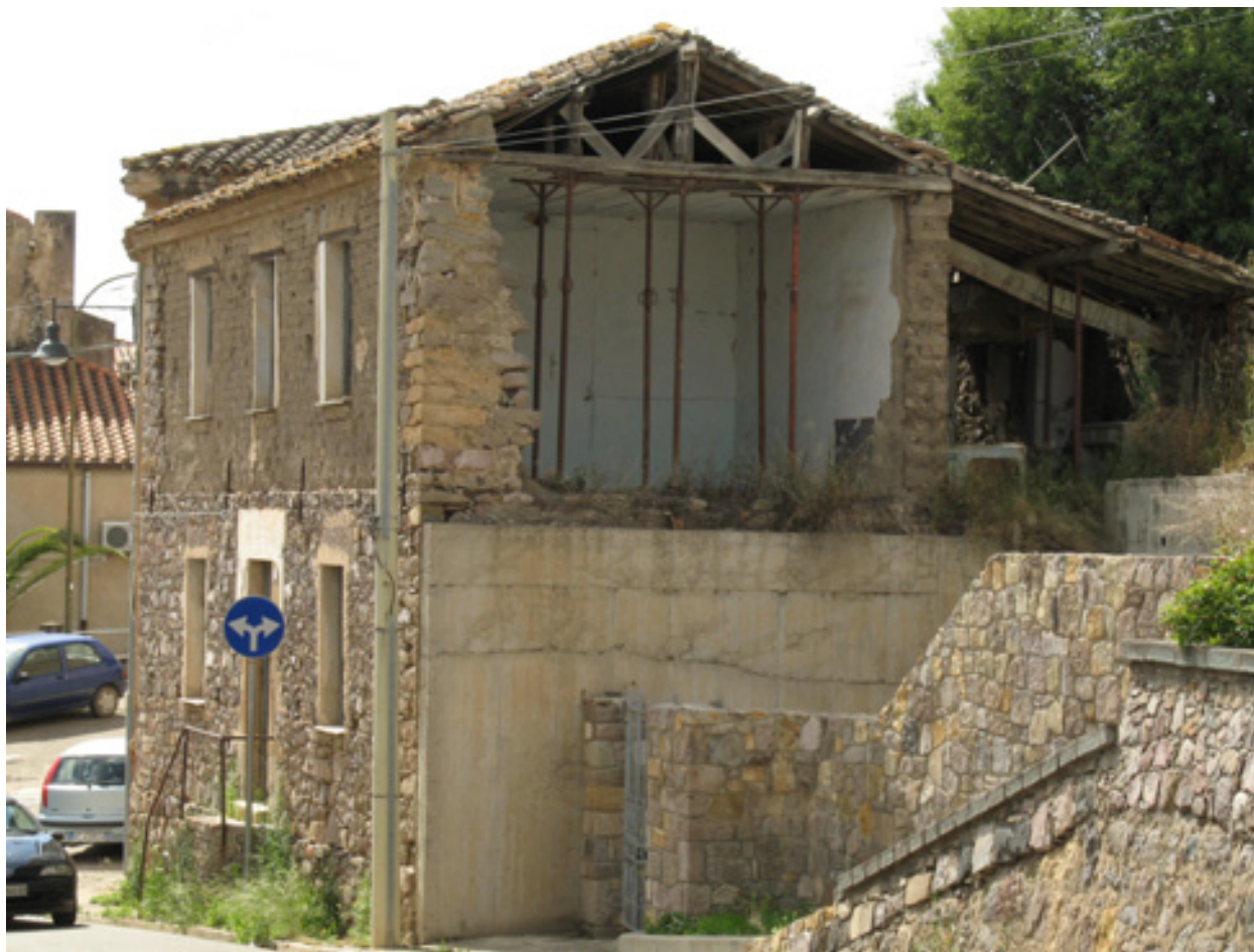
Fig. 4.2. Il degrado della scatola muraria. Sardara, nella bassa marmilla. Distacco totale di un paramento murario con il conseguente pericolo di crollo dell'intera scatola muraria.
