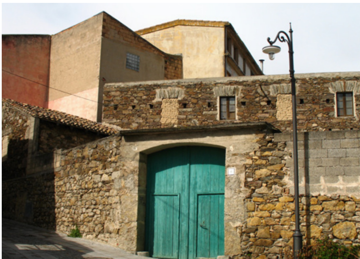
Fig. 4.7, in basso: Villanovatulo, nel Sarcidano. La sostituzione della copertura con un solaio orizzontale in laterocemento e l’inserimento di blocchi cementizi nel vivo delle murature in pietra o in ladiri, sono tra le patologie di degrado più diffuse nell’architettura tradizionale.
