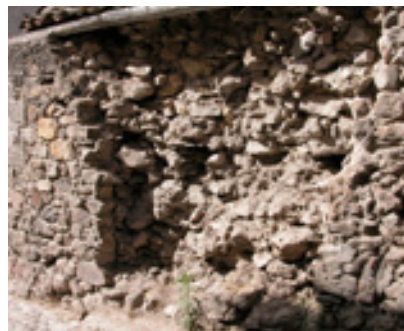
Fig. 4.5, in alto: distacco completo di un paramento murario a Villanovatulo, nel Sarcidano.
