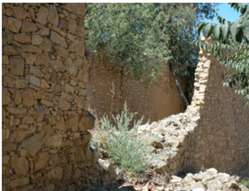
Fig. 4.4. Cedimento della muratura dovuto alla spinta della copertura. Simala, casa Diana.
